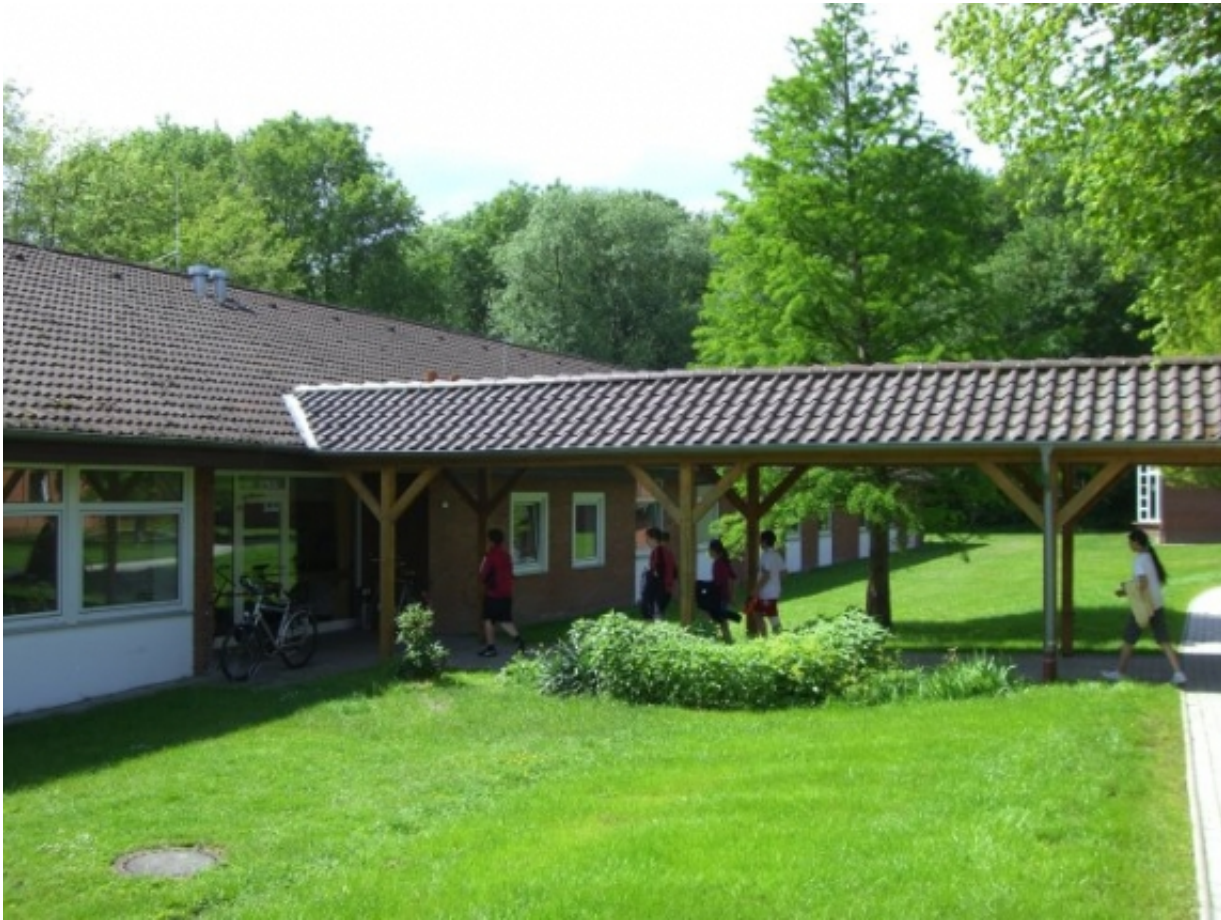
Überdachter Gang zu den Gästehäusern
